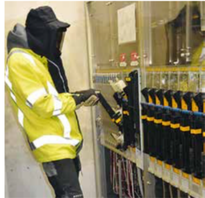
Wiedereinschaltung der Stromzufuhr nach der Montage der Klappwandler.
